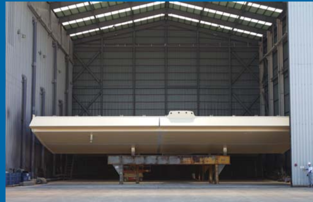
▲ 도장 작업 전경
