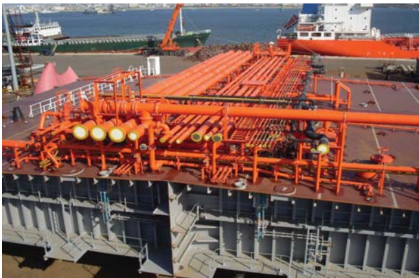
▲ P.E. 후 UNIT 2차 설치 전경
