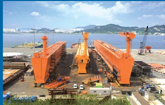
▲ 항만 P.E. 작업 전경
