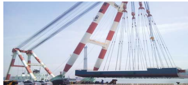
▲ PONTOON 하역/진수(삼아 2200호 F/C 하역,진수작업) 전경
