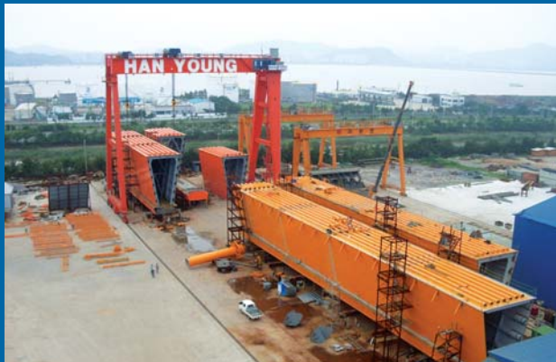
▲ 공장 P.E. 작업 전경
