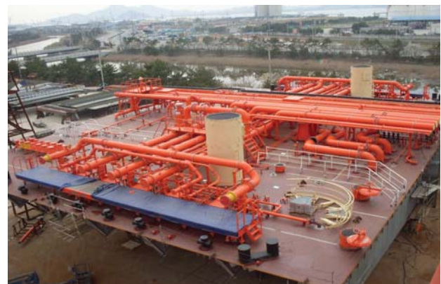
▲ P.E. 후 UNIT 3차 설치 전경
